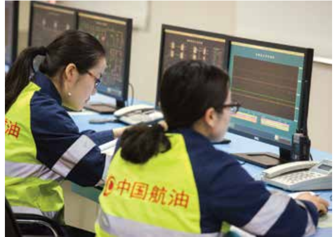
Round-the-clock monitoring at TSN-PEKCL Pipeline's control room 在天津管输公司管线控制室中进行24小时监控
