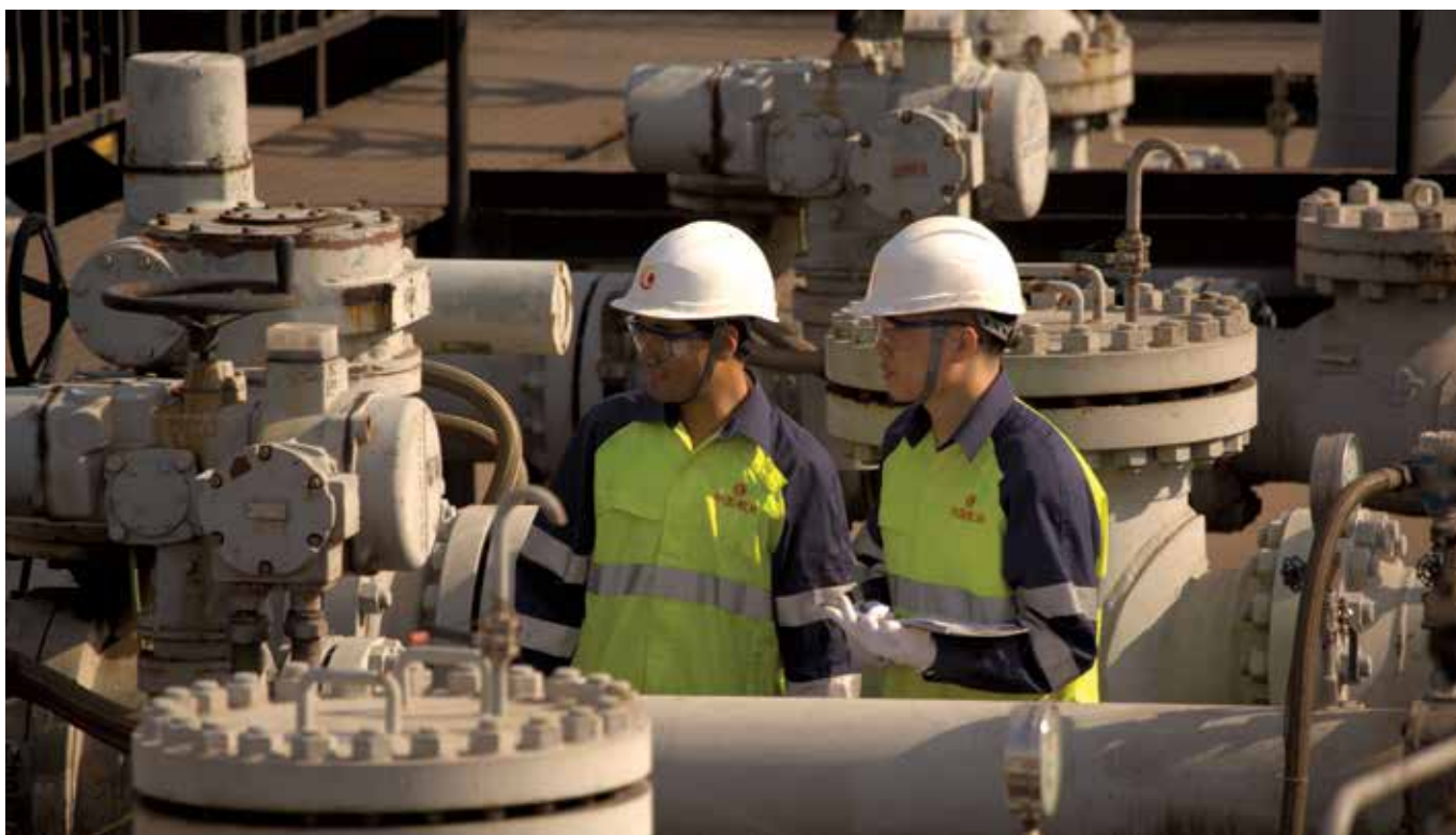
Routine checks at TSN-PEKCL Pipeline 管输公司的管线常规检查
